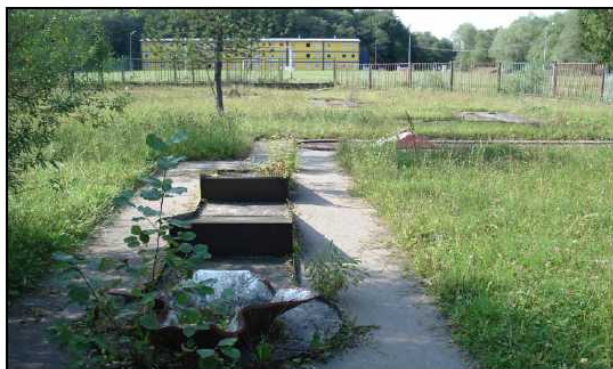
Pohľad na dezolátny stav hracích dráh
