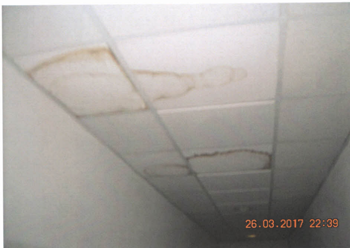
Zatečené chodby – poškodené kazety
